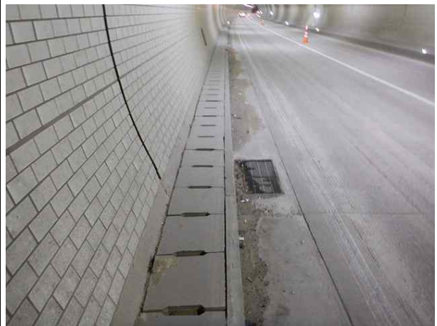
공동구 및 배수구 전경
